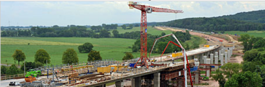
Autobahn im Bau nahe Eisenach (Foto: dpa)
