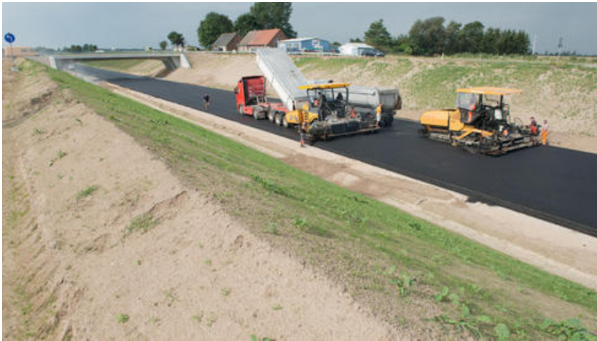
Eine Teerdecke wird auf einer neuen Straße aufgebracht.
