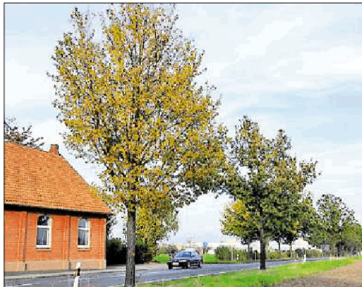
Allein an der Kreisstraße 221 zwischen Devese und dem Gewerbegebiet sollen etwa 30 Bäume gefällt werden. Zerm
