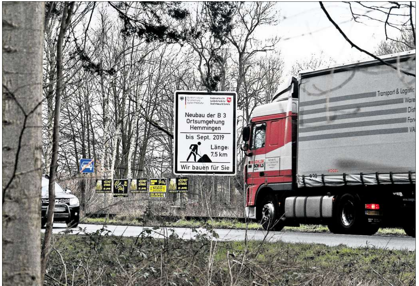
Jetzt geht's los: Das Schild vor dem Ortseingang von Hemmingen-Westerfeld weist auf den Grund der Bauarbeiten hin.
