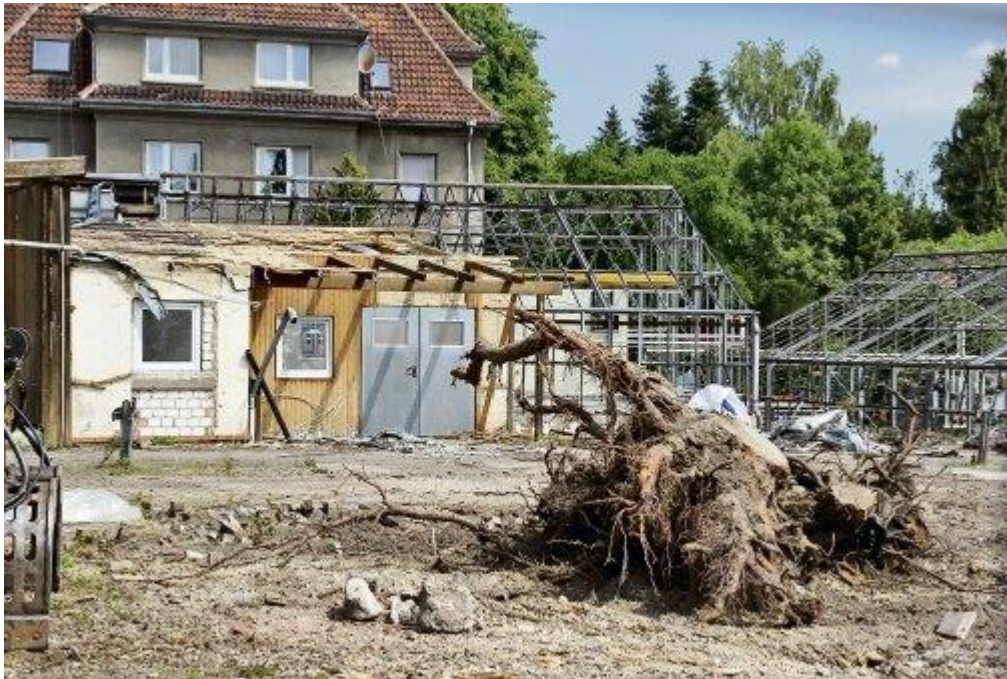
Abriss: Wo einst Blumen in Gewächshäusern blühten, soll die neue Schnellstraße entlangführen. Fotos: Schwarzenberger (2)
