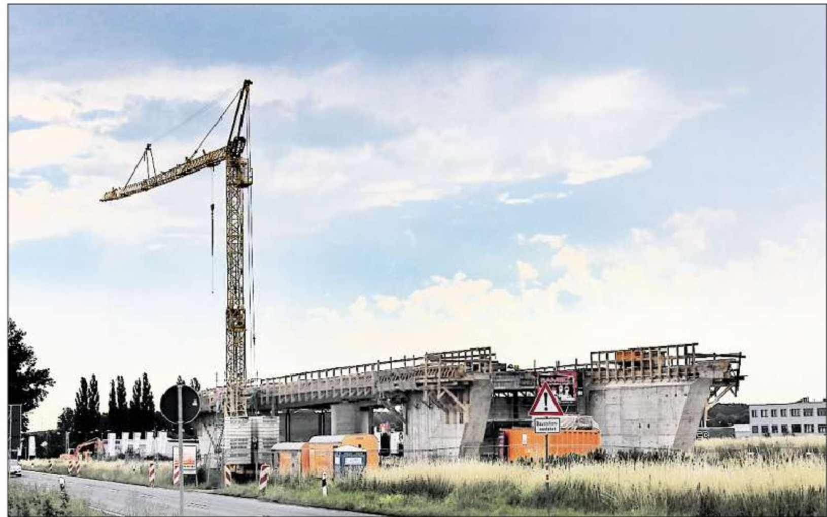
Beim Bau der B-3-Ortsumgehung ist der Schallschutz ein Streitthema.
