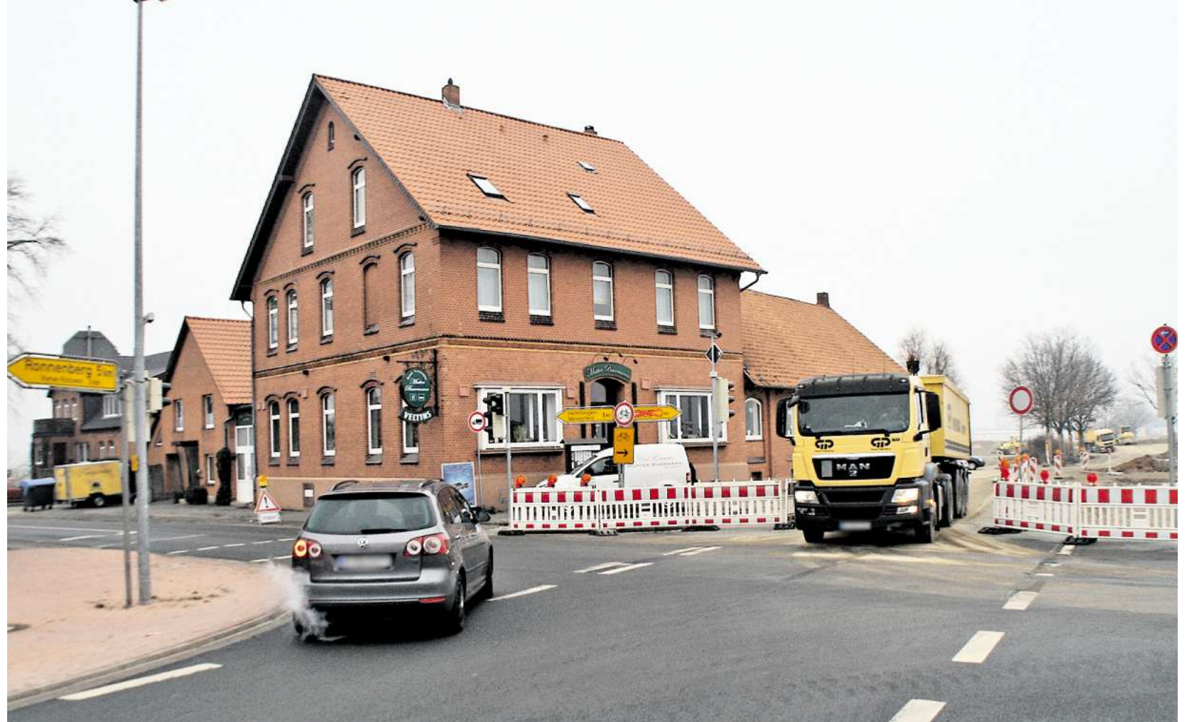
Hier wird bereits gebaut: Zu den Folgen der entstehenden B-3-Orts- umgebung gibt es viele unterschiedliche Prognosen.
