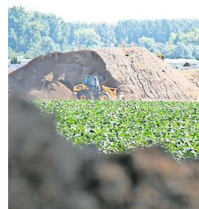
Wegen des Baus der B-3-Ortsumgehung sind hohe Erdberge aufgeschüttet. Provisorische Wege durch die Baustelle lehnt die Landesbehörde aus Sicherheitsgründen ab.
