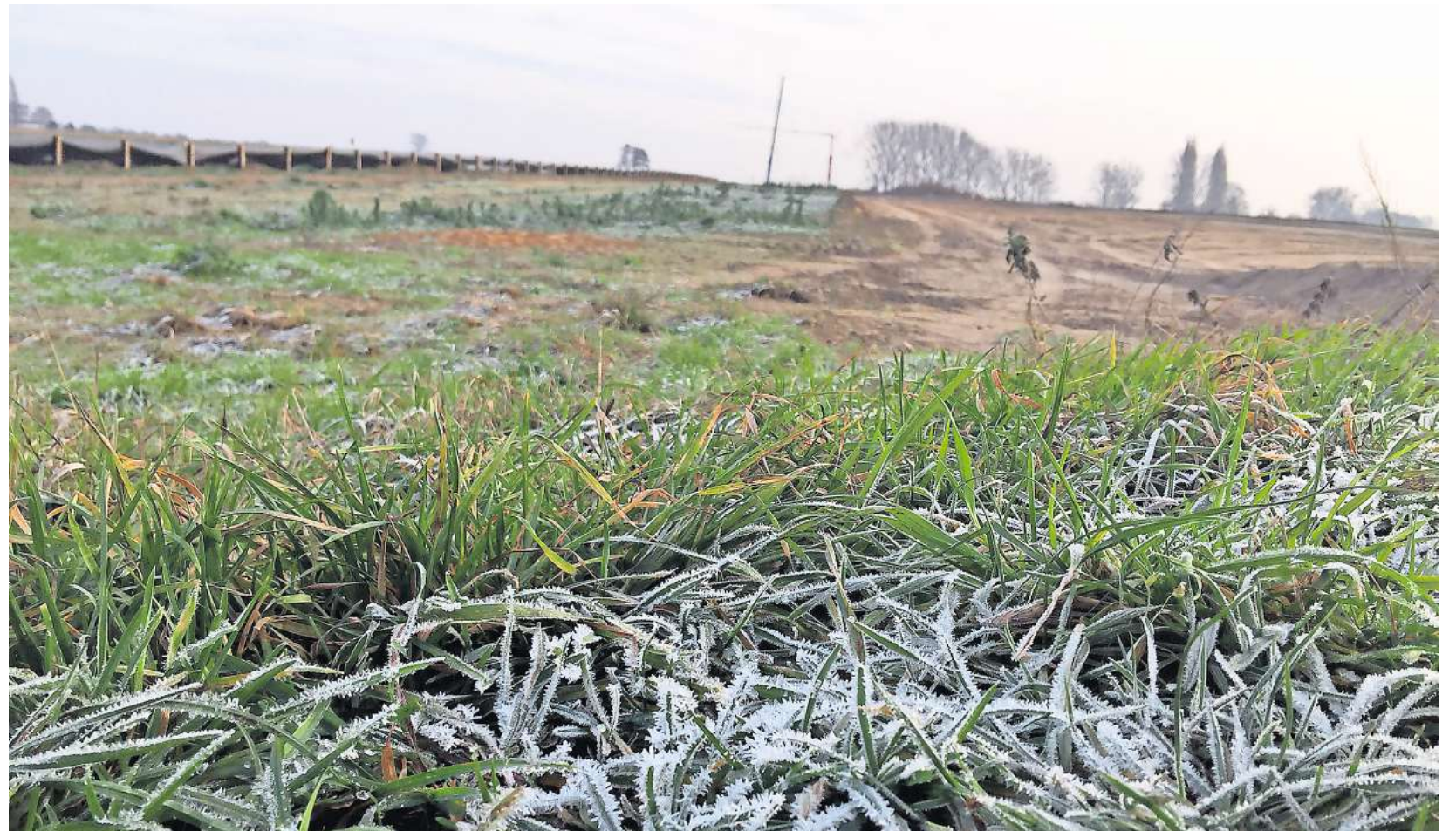
Große Schneisen in der Landschaft: Am Rand der Baustelle für die B-3-Umgehungsstraße in Arnum hat sich Raureif gebildet.
