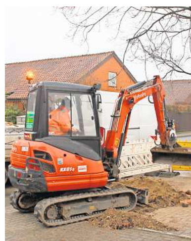
Nach mehrwöchiger Pause haben Bauarbeiter damit begonnen, die Parkplätze freizuräumen.
