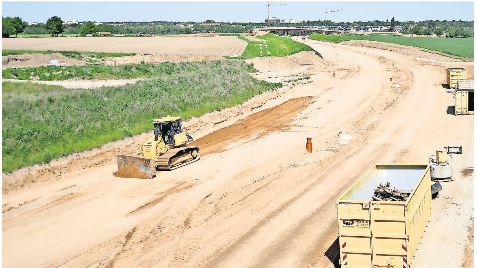
Die Bauarbeiten gehen voran, wie der Blick von der neuen Brücke zwischen Weetzener Landstraße und Devese zeigt.
